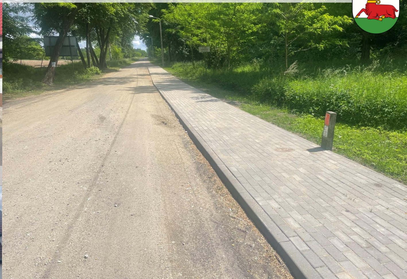
Przebudowa drogi gminnej w Dębogórze- budowa odcinka chodnika.
