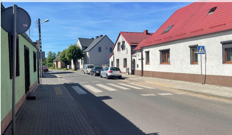
Przejście dla pieszych na ulicy Błonie w Wieleniu.
