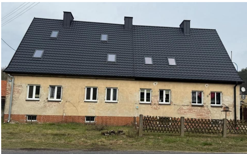
Nowe Dwory 99, budynek po remoncie pokrycia dachowego.
