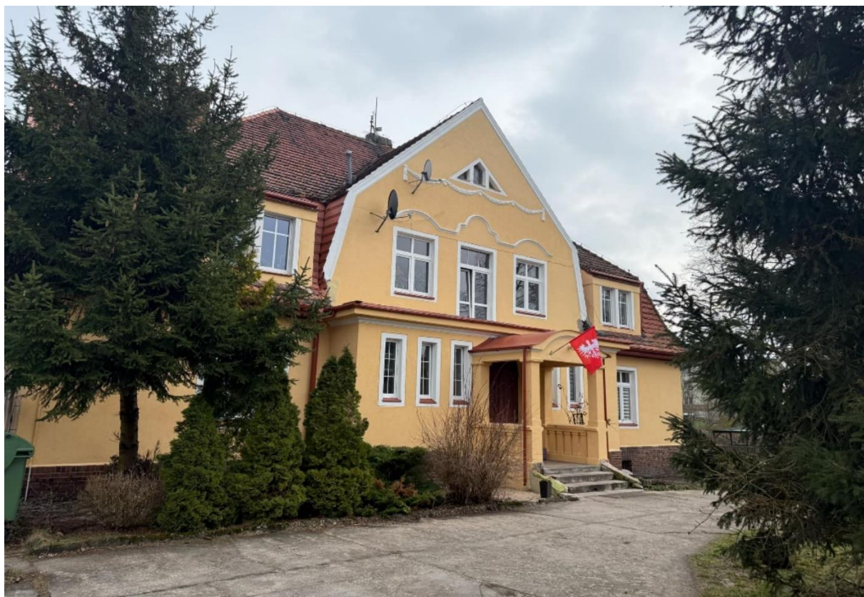
Miały, ul. Fabryczna 2, budynek po remoncie elewacji
