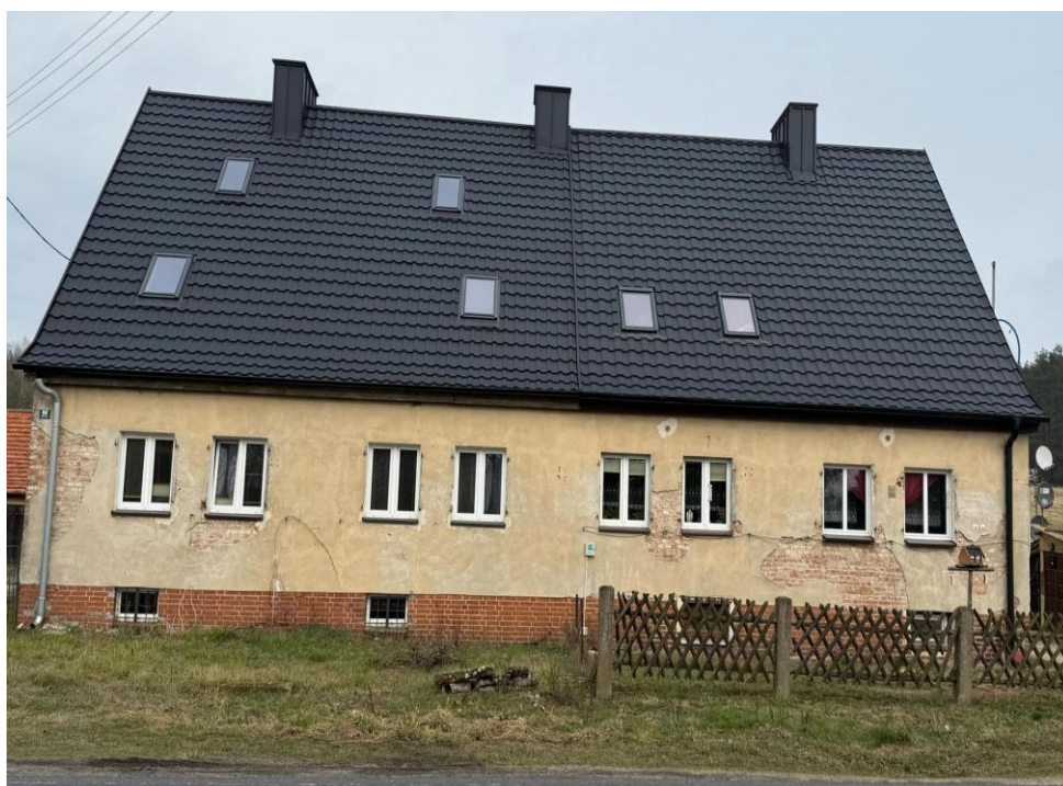
Budynek komunalny Nowe Dwory 99 po remoncie dachu
