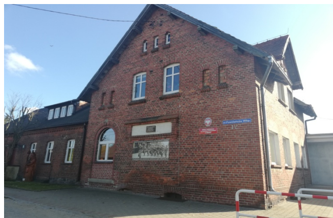
Budynek Szkoły Podstawowej
